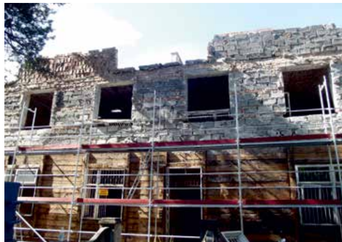
Mur pod konstrukcją sumikowo-łatkową.
